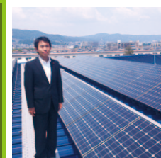
東レエンジニアリング 瀬田工場 太陽光発電システム調査
